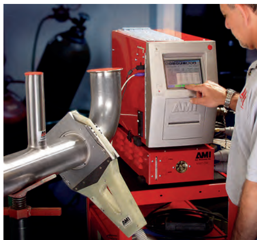
图6 不锈钢管道的自动轨道焊接（照片来源：Arc Machines公司）
